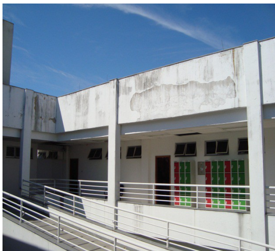
Parede externa do prédio
