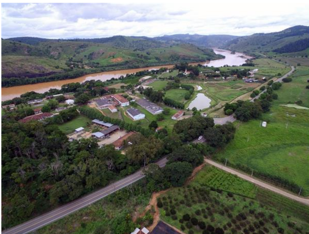
Figura 1 - Vista aérea de parte do Campus Itapina.
