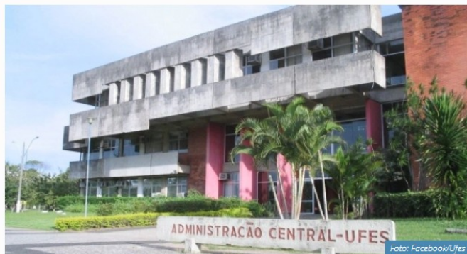
Prédio da administração central da Ufes
